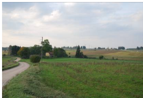
3.22. attēls. Skats uz elektropārvades līniju Līgciema apkārtņē
