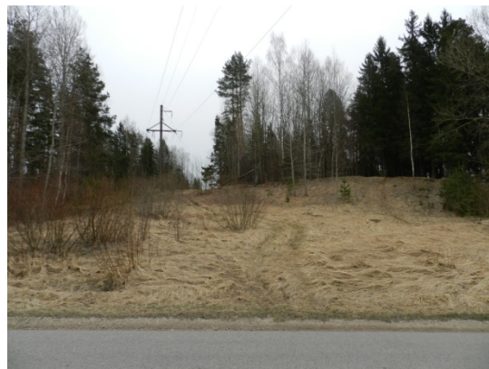
3.7.15. attēls. Milzkalnes Baznīcas kalns un to šķērsojošā 110 kV elektrolīnija
