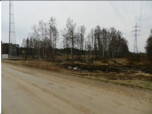
23. Romu-Kalniņu apmetne un esošā elektropārvades līnija no dienvidrietumiem
