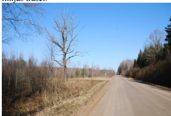
3.7.5. attēls. Skats uz plānoto trases vietu pie Toras upītes caurtekas uz Vidrižu - Bedrīšu ceļu
