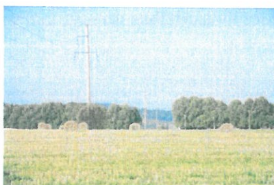
9. attēls. Elektrolīnijas trase un tai izveidotais pārrāvums alejā pie Vecmokām
