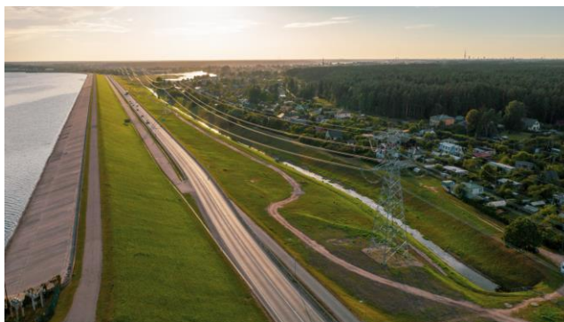
9. att. Rīgas TEC-2 – Rīgas HES 330kV elektropārvades līnija
